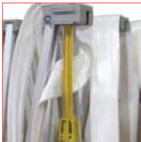
Ne pas coincer les connecteurs dans la sangle velcro
